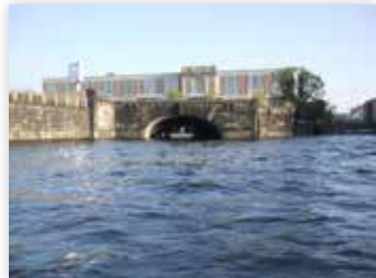
Freiheits- und Einheitsdenkmal in Berlin-Mitte denkmalgeschützt Grundsanierung des Sockels
