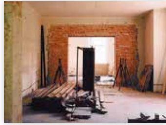
Wohnhaus in Potsdam-Babelsberg Umbau und Instandsetzung
