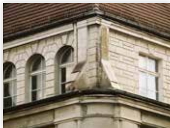
Oberwasserstraße 13 in Berlin-Mitte Umbau eines Lager- und Bürogebäudes zu einem Ausbildungszentrum für Diplomaten
