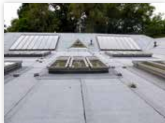
Kinderhaus Waldschulallee in Berlin-Charlottenburg denkmalgeschützt Sanierung des Daches
