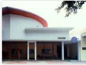
Goethe-Institut in Jakarta / Indonesien Umbau, Erweiterung um ein Saalgebäude und eine Bibliothek, Instandsetzung
