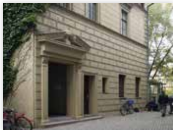
Ballhaus Naunynstraße in Berlin-Kreuzberg denkmalgeschützt
