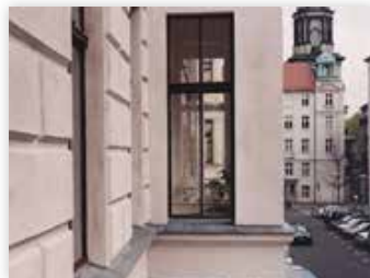
Mietshaus in Berlin-Mitte denkmalgeschützt Umbau und Instandsetzung
