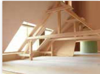
Wohnhaus in Tietzow Umbau, Instandsetzung und Dachausbau
