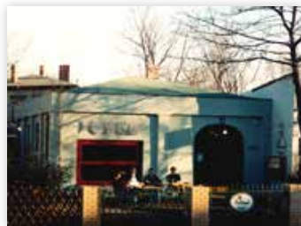
Café in Berlin-Treptow denkmalgeschützt, Umbau und Instandsetzung eines Tanzsaales
